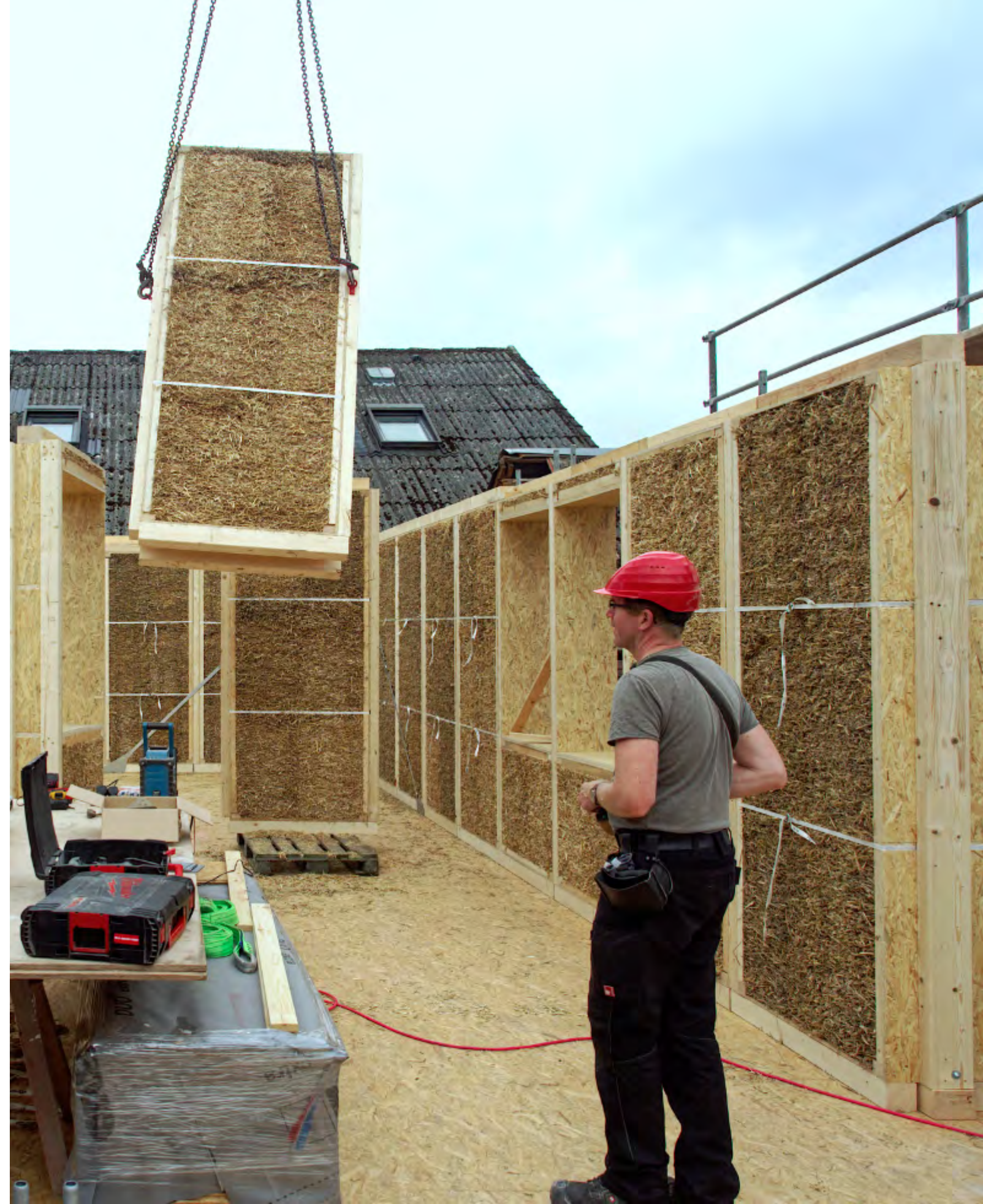
Im Obergeschoss seines Strohballenhauses in Wittingen hat Bauunternehmer Dirk Schulz ein Wandmodul an den Baukran gehängt. Mit der Fernbedienung bugsiert er es exakt an die Stelle, an der es in die Wand eingesetzt werden soll.
